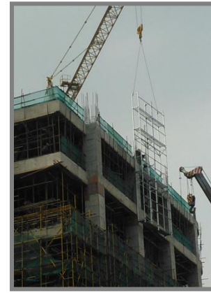
高空整体吊装
