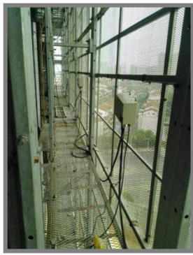
爬架的导轨及防坠器
