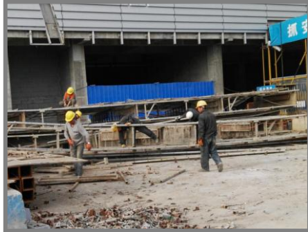
地面进行架体拆卸
